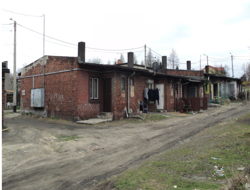
Zdjęcie 5. Zdjęcie przedstawia budynek mieszkalny znajdujący się w obszarze rewitalizacji nr 2
