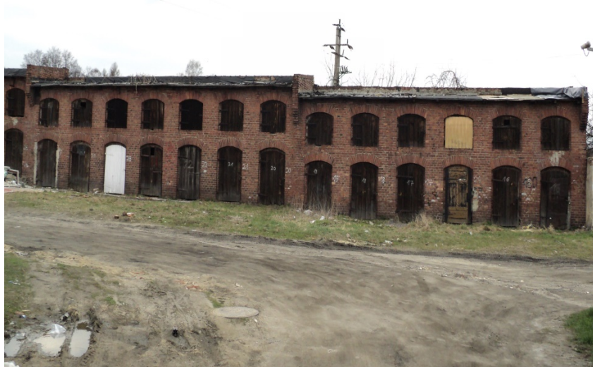
Zdjęcie 6. Zdjęcie przedstawia budynek gospodarczy znajdujący się na obszarze rewitalizacji nr 2
