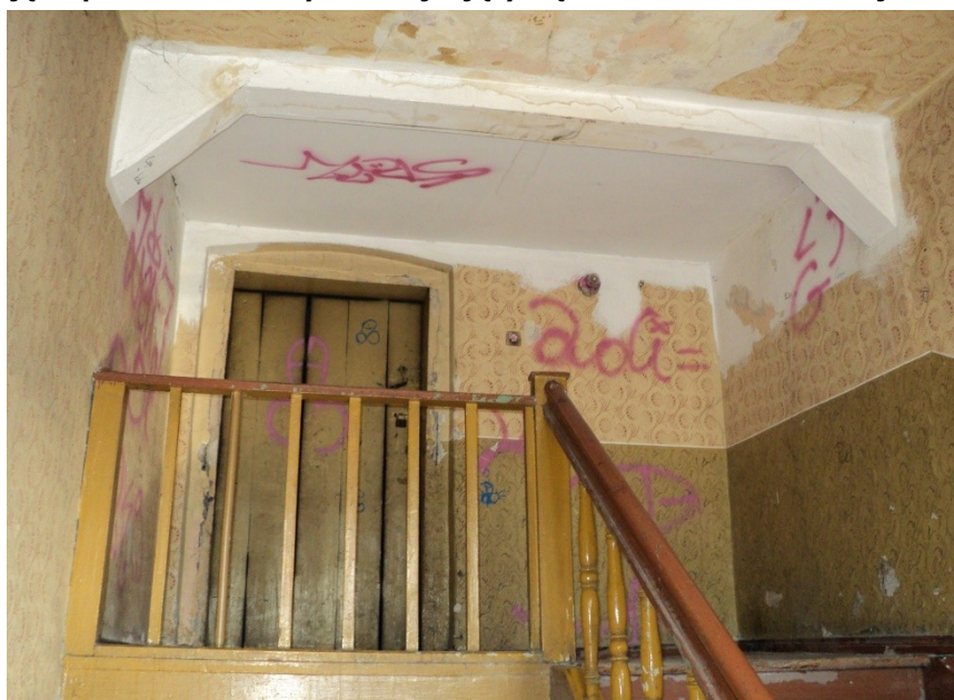
Zdjęcie 3. Zdjęcie przedstawia budynek znajdujący się w obszarze rewitalizacji nr 1
