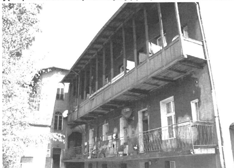
Zdjęcie 2. Zdjęcie przedstawia budynek znajdujący się w obszarze rewitalizacji nr 1
